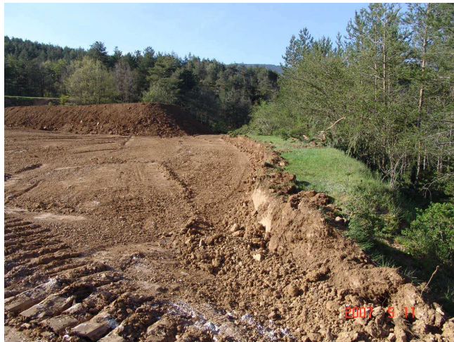
Fig.1.- Retirada del suelo vegetal
