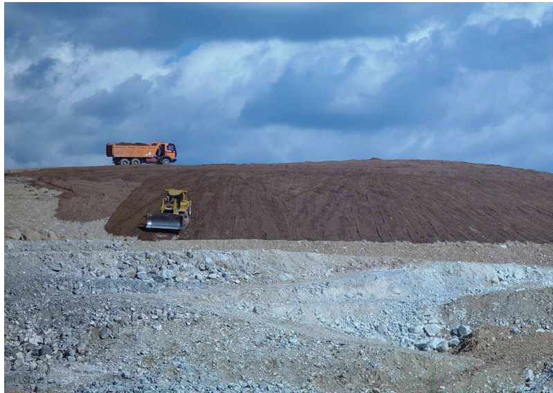
Fig.6.- Extendido de tierra vegetal
