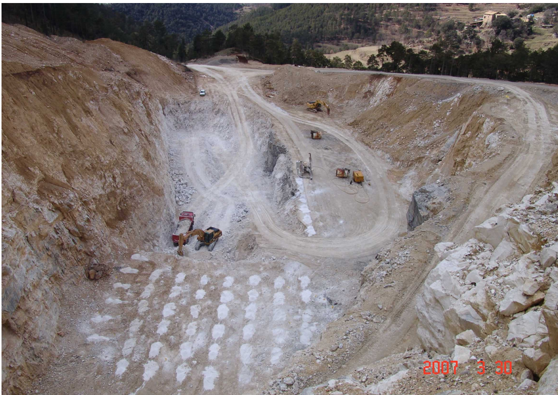
Fig. 3.- Zona perforada para ser volada
