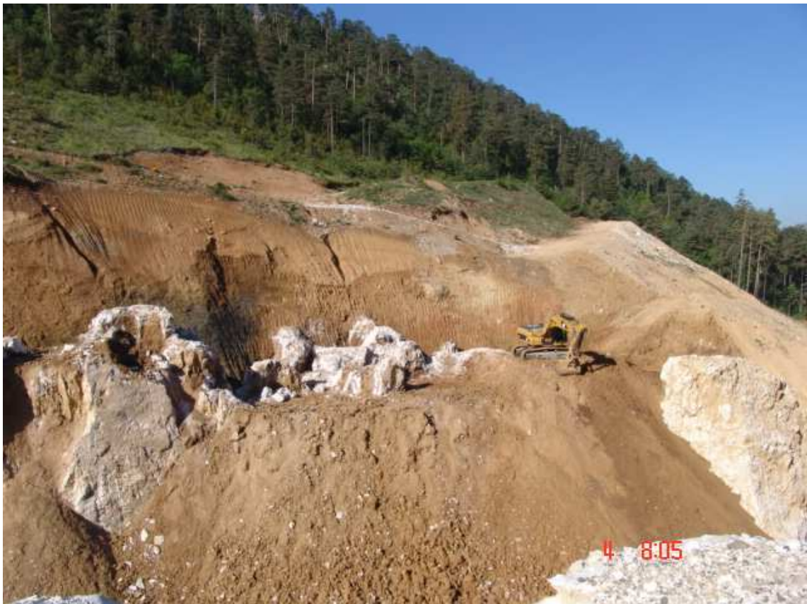
Fig.- 2.- Retirada del estéril que cubre el mineral
